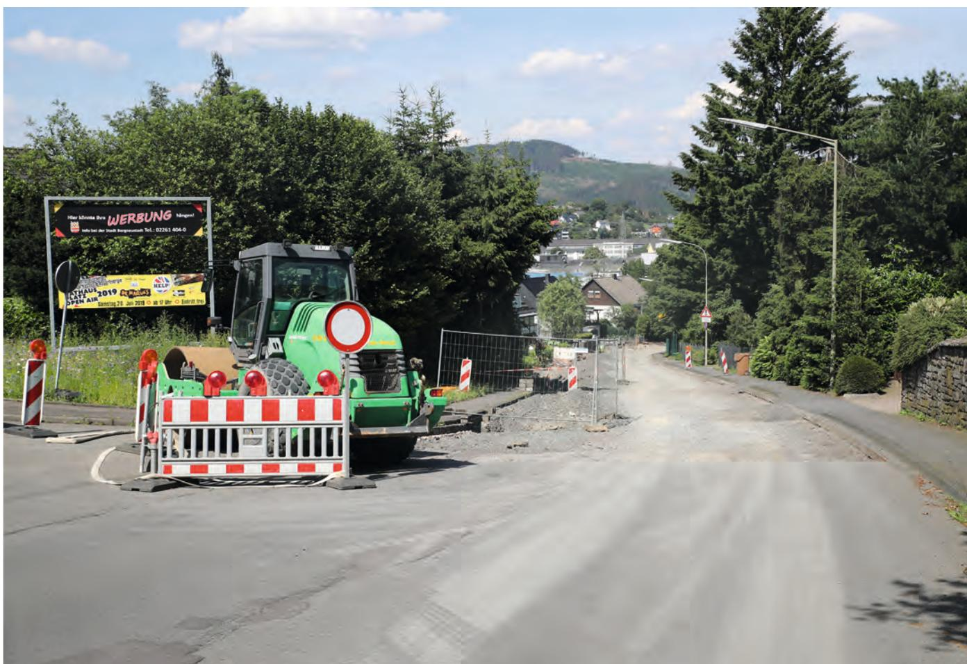
**Baumaßnahme Südring** - Zurzeit wird zwischen Othestraße und Enneststraße die neue Wasser- und Gasleitung verlegt und Filterschächte an den Straßenabläufen eingebaut. Zwischen Enneststraße und Anschlussstelle Pochwerk wird seit Ende Juni der komplette Asphalt abgefräst. Die Baumaßnahme ist im Zeitplan und der Verkehr über die Umleitungsstrecke läuft problemlos.
