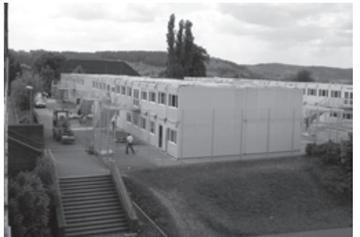
Nun ist es soweit: Die Aufstellung des Containerdorfs für die Hauptschule Auf dem Bursten ist bis auf kleine Restarbeiten abgeschlossen. 216 Container bilden in vier zweigeschossigen Blöcken bis zum Ende des nächsten Schuljahres die vorübergehende Unterkunft der Hauptschule.
