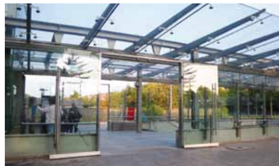
Verglaste Eingangshalle zu einer U-Bahn-Station
