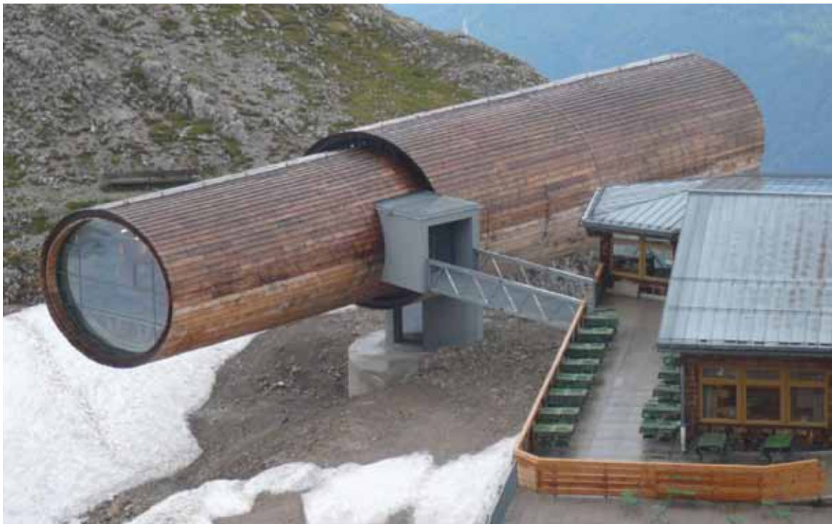
Das „Fernrohr“ an der Gipfelstation der Karwendelbahn. Auch von außen ist die Markierung im Vogelschutzglas kaum zu erkennen.
