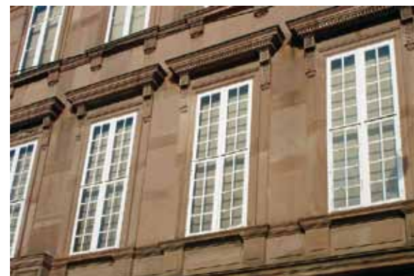
Bei der Sanierung älterer Bauten macht der Einsatz von Sprossenfenster nicht nur aus Sicht der Denkmalpflege Sinn.
