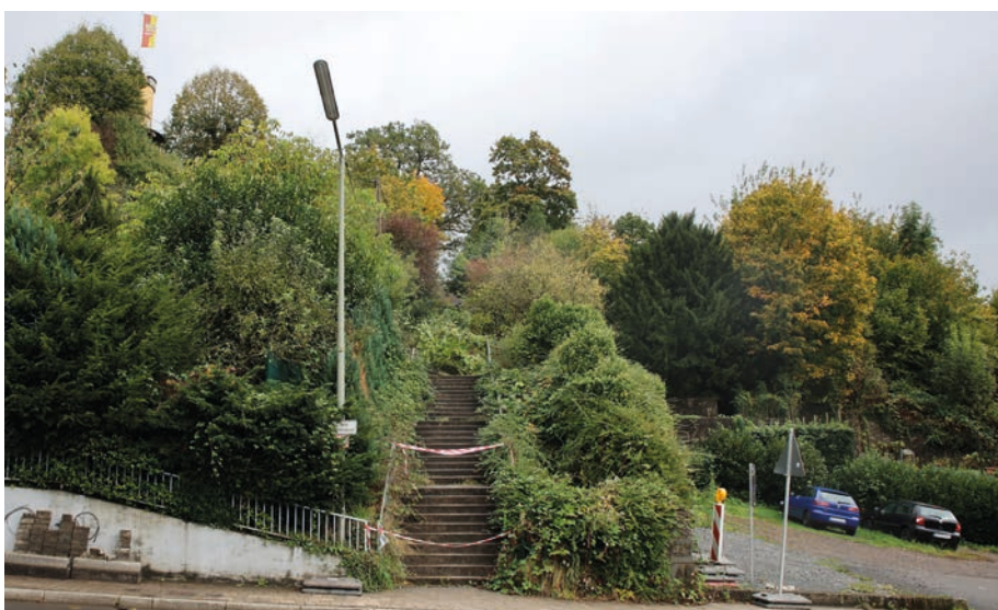
Die Baumaßnahmen am „Schmittloch“ laufen bereits.
